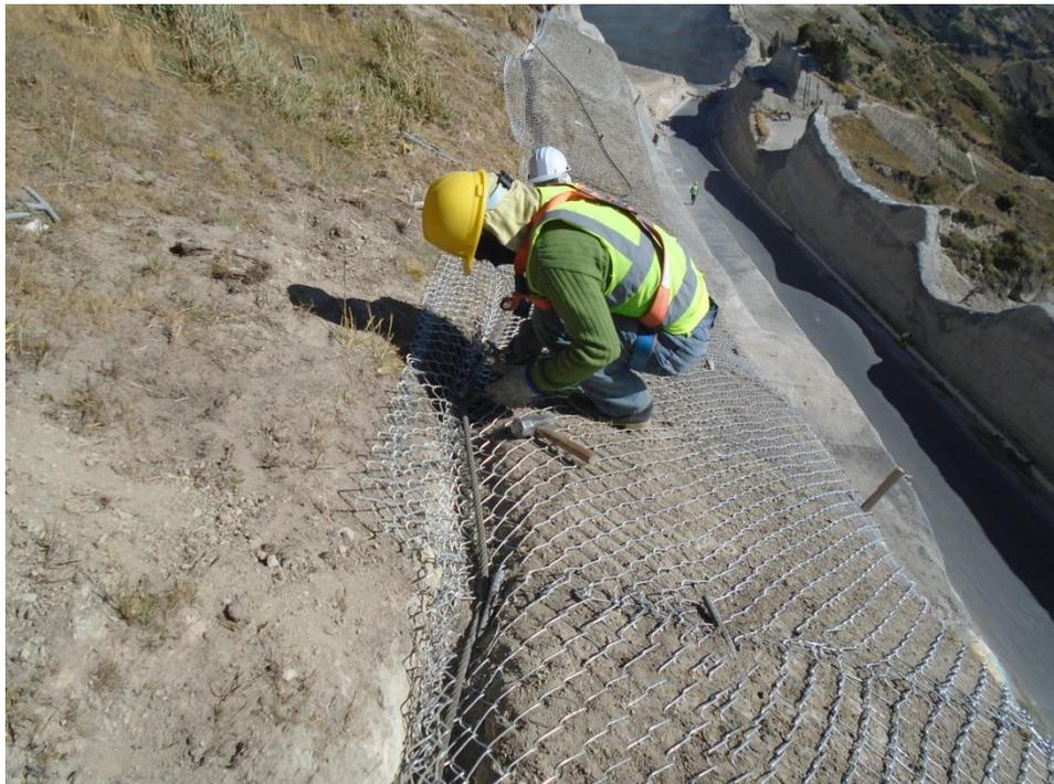
**FOTO N° 17: COLOCACIÓN DE ANCLAJES DE HIERRO
