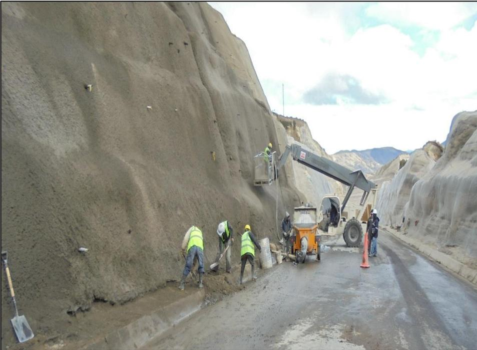
**FOTO N° 13: PERFILADO DE TALUD CON PENDIENTE AL 75% DE INCLINACIÓN DEL TALUD**
