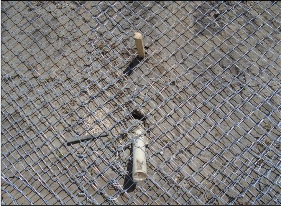
**FOTO N° 12: HORMIGÓN LANZADO PARA ESTABILIZACIÓN DE TALUDES**
