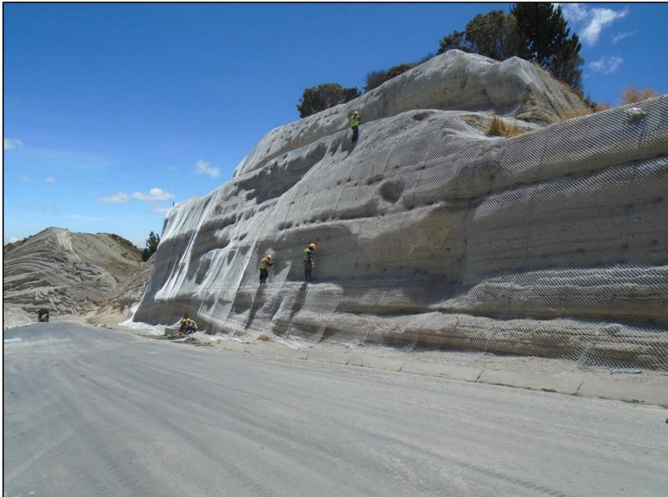
**FOTO N° 19: COLOCACIÓN DE CABLE DE ACERO EN LA BASE DEL TALUD PARA ANCLAJE DE MALLA**
