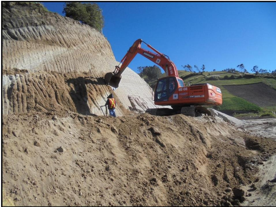
**FOTO N° 14: DESALOJO DEL MATERIAL DE EXCAVACIÓN DEL TALUD**
