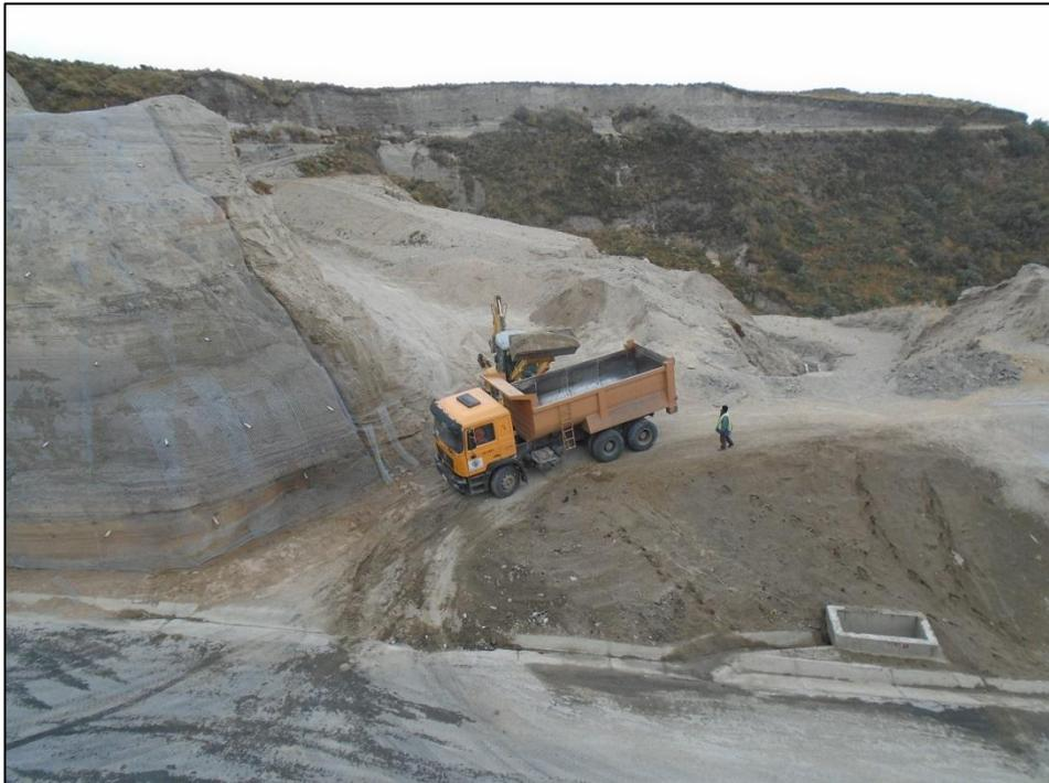
**FOTO N° 15: EXCAVACIÓN PARA DENTELLÓN DE ANCLAJE Y SU PROTECCIÓN CON MALLA**
