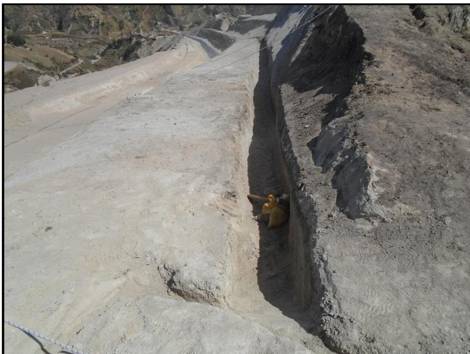
**FOTO N° 29: FUNDICIÓN DE HORMIGÓN EN CUNETA DE CORONACIÓN**
