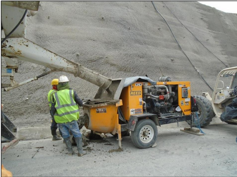
**FOTO N° 26: HORMIGÓN LANZADO COLOCADO EN CAPAZ PARA
