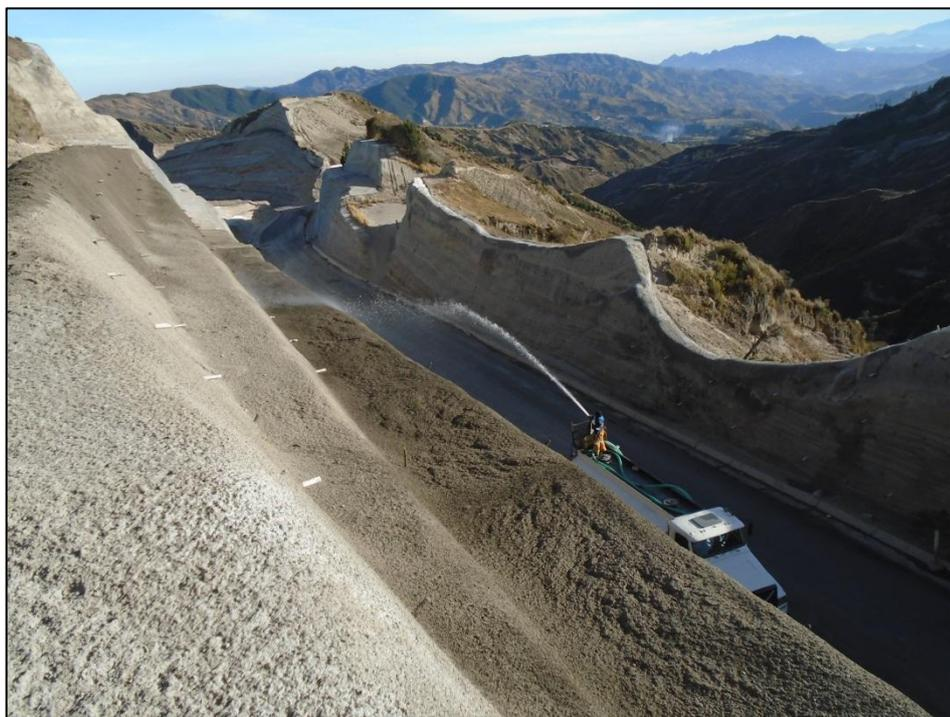
**FOTO N° 28: EXCAVACIÓN EN LA CUMBRE Y BERMA DEL TALUD PARA CUNETETA DE CORONACIÓN**
