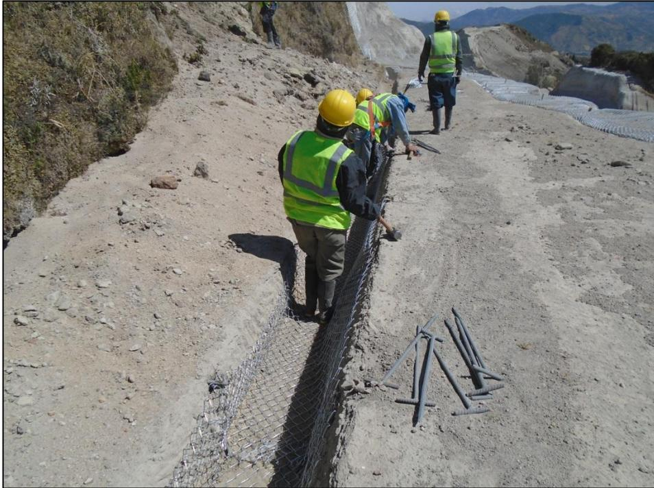
**FOTO N° 16: COLOCACIÓN DE CABLE DE ACERO PARA SUJETACIÓN DE MALLA ESLABONADA**
