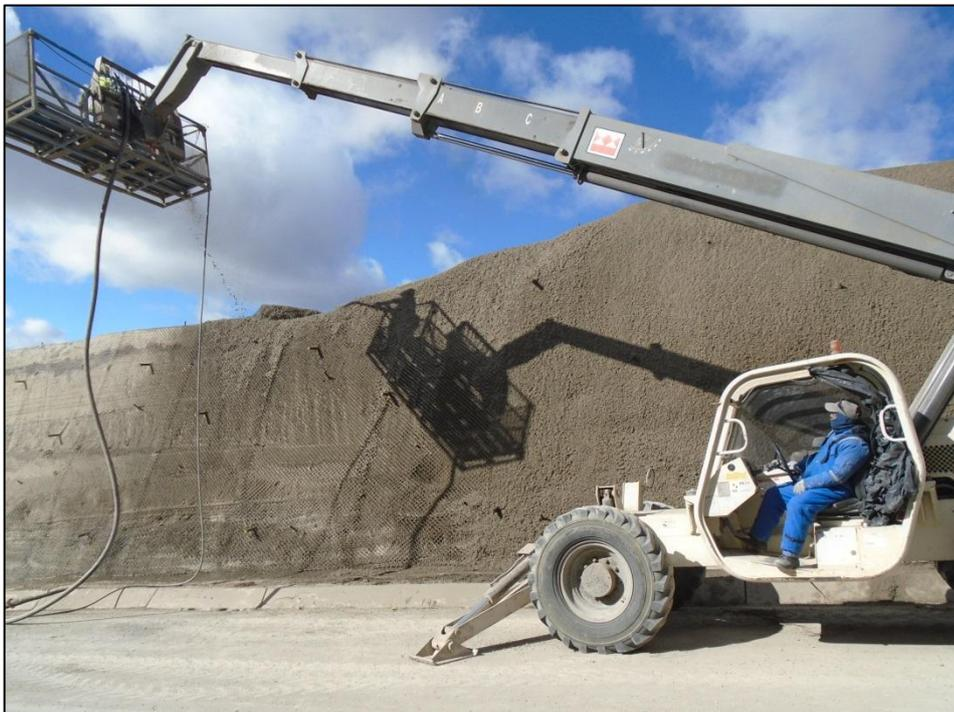
**FOTO N° 27: CURADO DE HORMIGÓN LANZADO MEDIANTE UN TANQUERO CON CAÑÓN**
