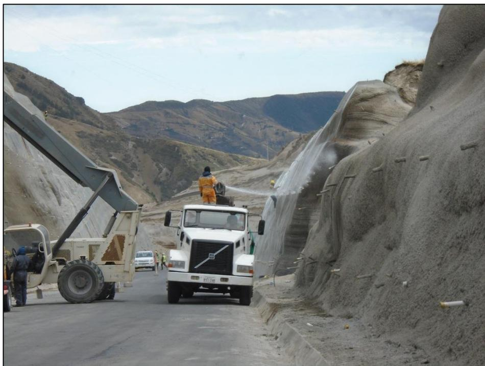
**FOTO N° 22: COMPROBACIÓN DE ESPESORES PARA COLOCACIÓN DE HORMIGÓN LANZADO**
