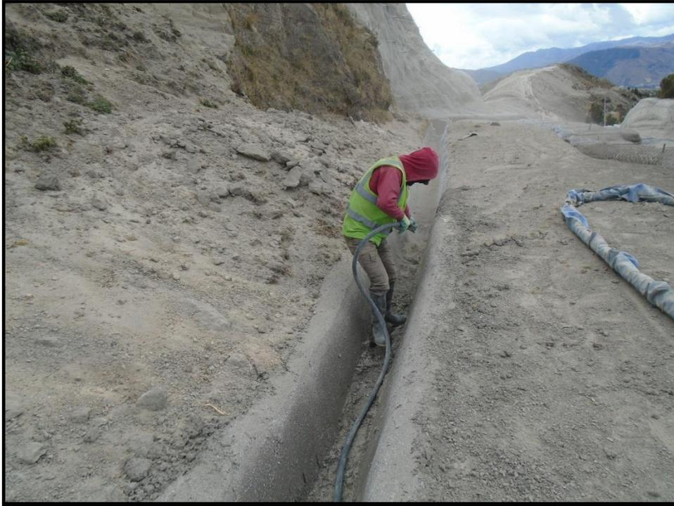
**FOTO N° 30: FUNDICIÓN DE BAJANTES PARA EVACUACIÓN DE AGUAS DE CUNETAS DE CORONACIÓN**
