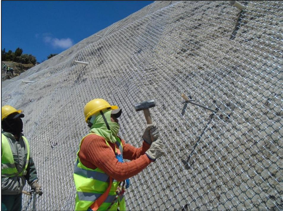
**FOTO N° 18: COLOCACIÓN DE MALLA ESLABONADA SOBRE LA
