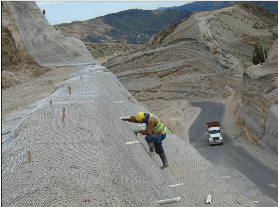
**FOTO N° 21: HUMEDICIMIENTO DEL TALUD PARA COLOCACIÓN DE HORMIGÓN LANZADO**
