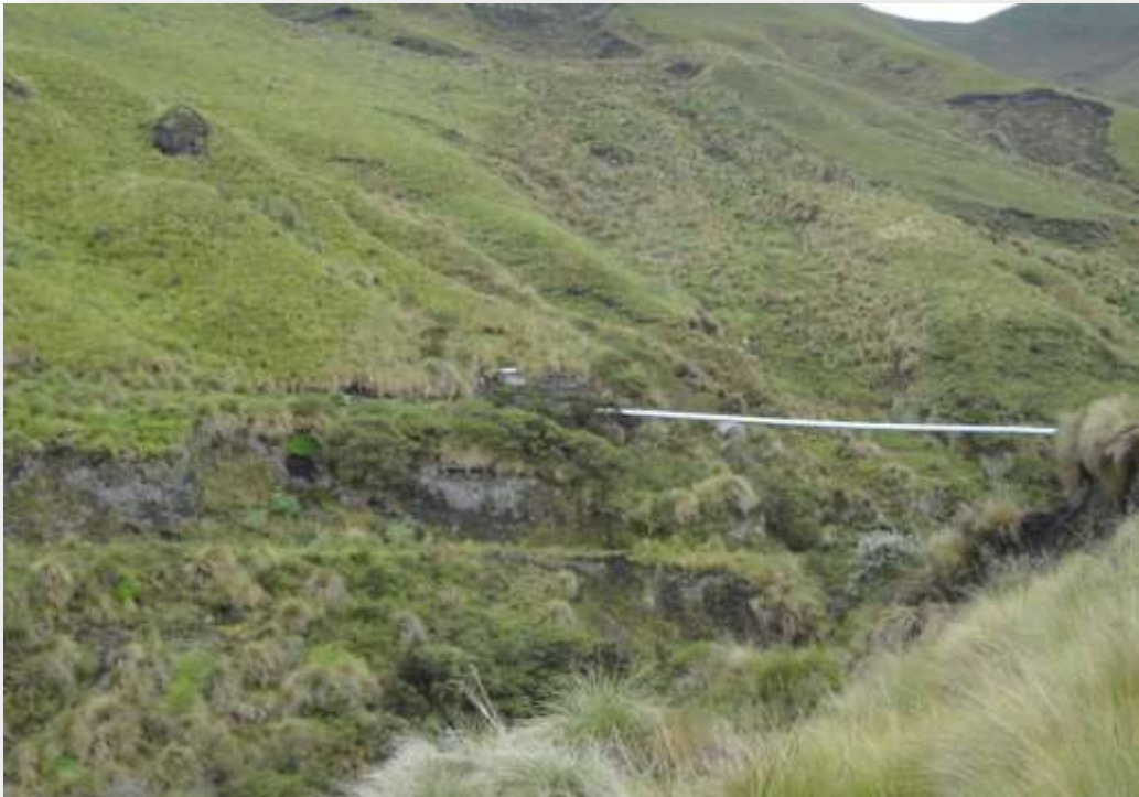
Fotografía N° 1 Conducción del agua de riego proveniente de la vertiente de los páramos de Toro Rumí y Quillopacna
