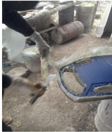
Figura 6-13 Retirar excesos del material de los bordes
