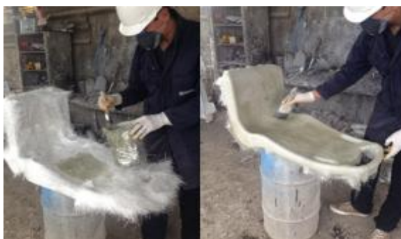
Figura 6-11 Untar la resina sobre fibra de vidrio parte frontal
