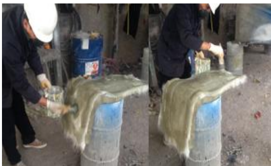
Figura 6-12 Untar la resina sobre fibra de vidrio parte posterior
